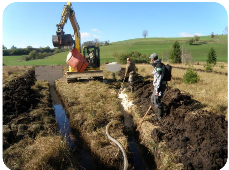
Figure 18 : Comblement des drains du bas-marais du Crossat (2014)
